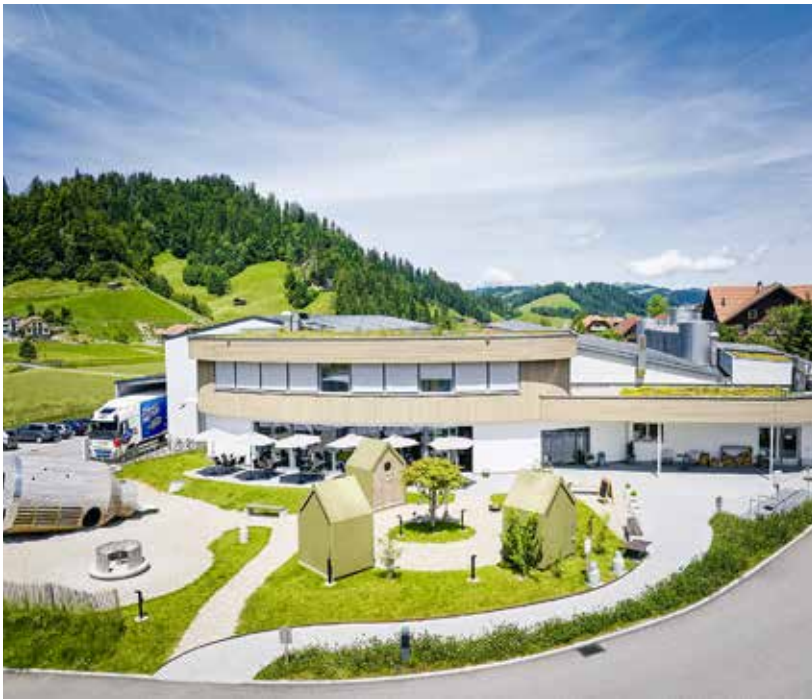
Die Bergkäserei Marbach AG produziert ihre Produkte vollständig mit Holzenergie vom Wärmeverbund. Die PV-Anlagen auf dem Gebäude decken zusätzlich einen Teil des Strombedarfs ab.
