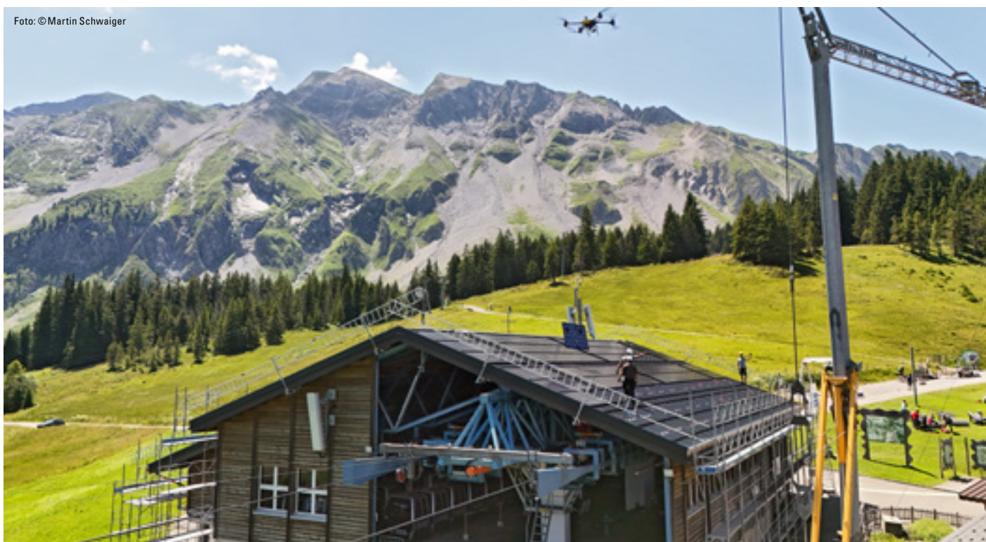
700 Solarpanels liefern lokal erzeugten Strom für den Bahnbetrieb sowie das Erlebnis-Restaurant Rossweid.
