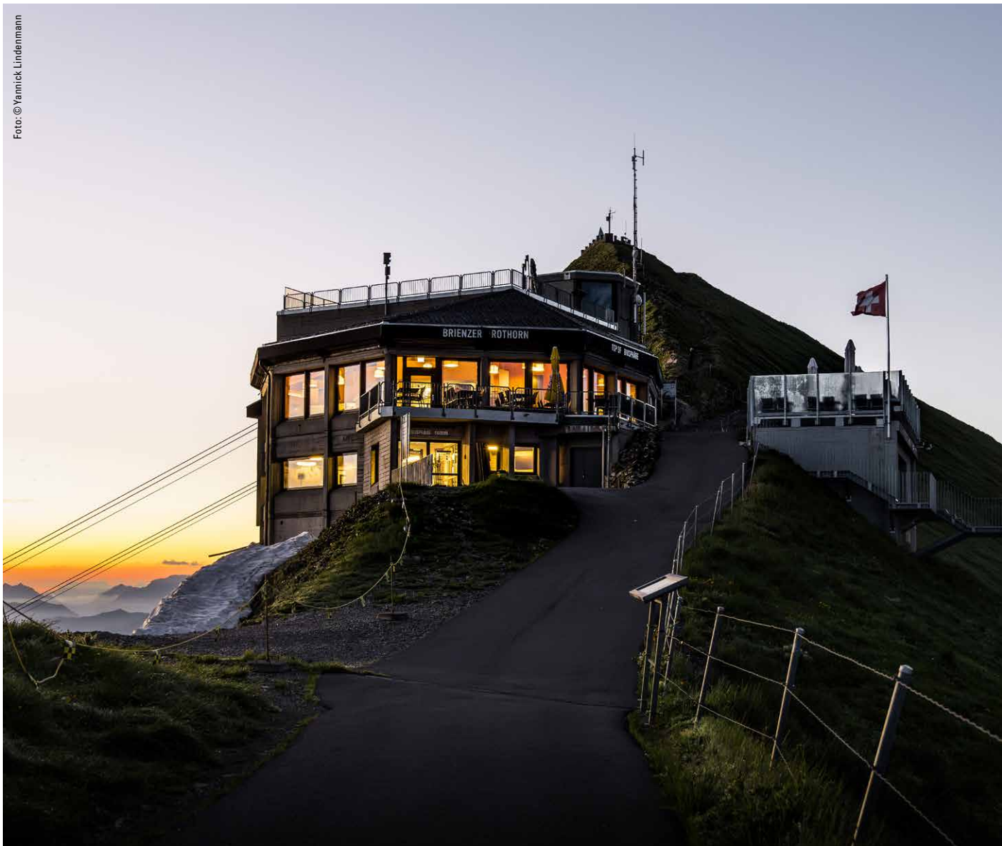
Seit Anfang Juli 2024 erstrahlt das Gipfel-Restaurant Rothorn in neuem Glanz.
